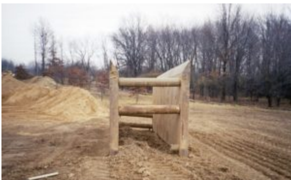
Figura 2. Escudo (El escudo fue retirado de la zanja con una excavadora y colocado a
